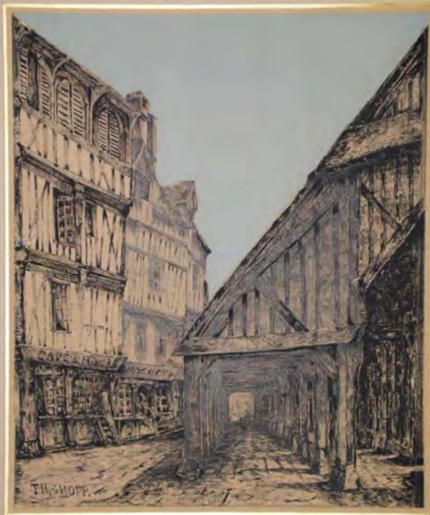
EXTRÉMITÉ SUD DE LA HALLE DES LOUVIERS
